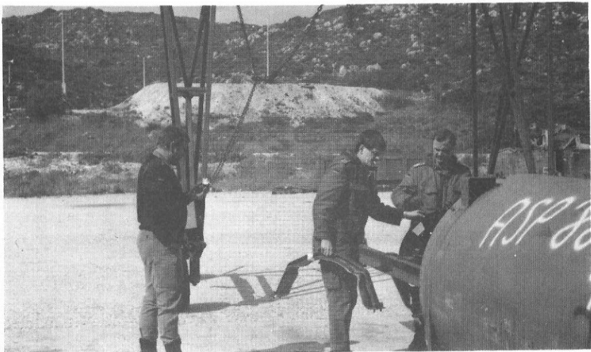
Die Arbeit im Montagebereich beginnt
